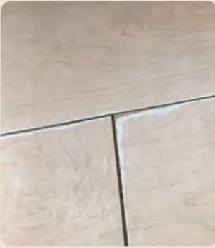
摩耗して下地が露出
