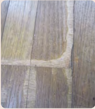
摩耗して下地が露出
